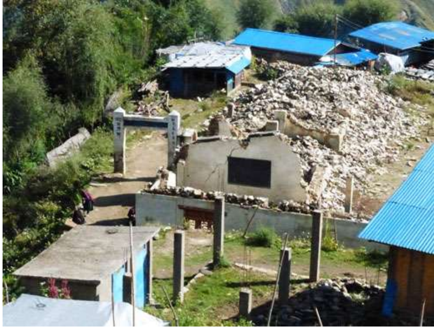
Le portail d'entrée du groupe scolaire le bâtiment « A ».
