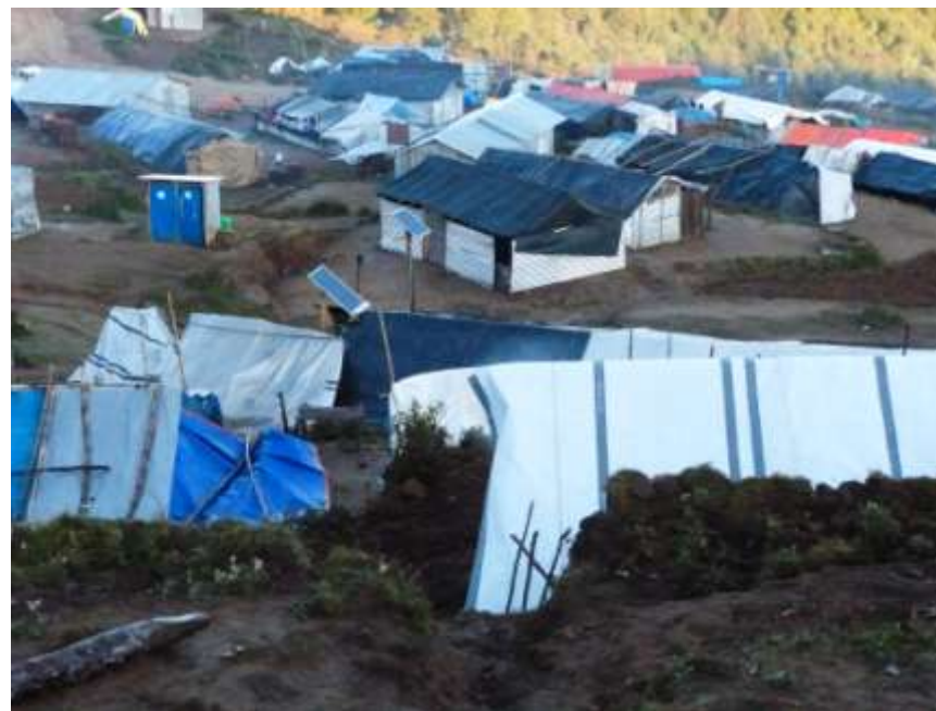
Des panneaux solaires fournis et installés par Electriciens sans Frontières servent à éclairer le camp.
