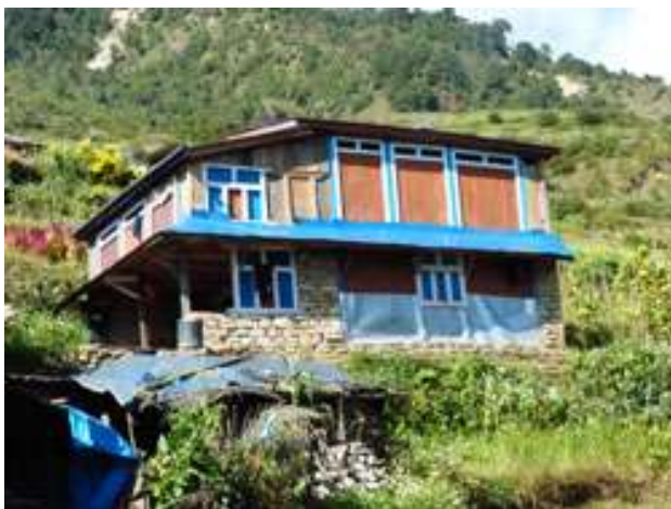
Une maison en cours de rénovation.
