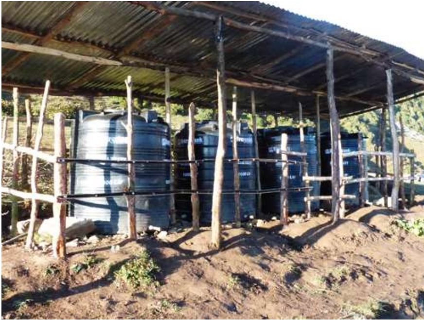
Une des deux réserves d'eau.
