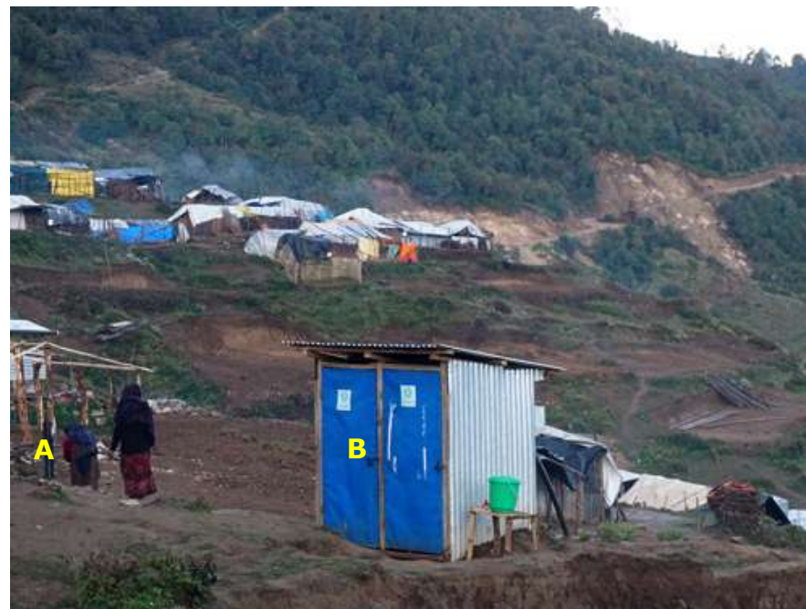
Repère A , vue d'un des 12 points d'arrivée d'eau, Repère B vue d'un des 40 WC du camp
