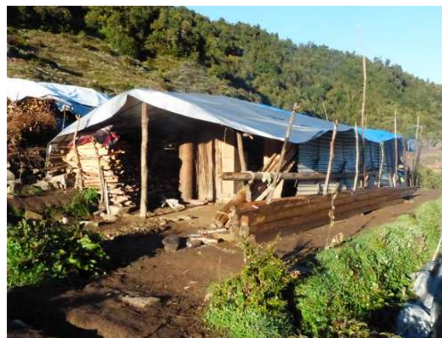
Vue d'un abri construit en bois, tôles et bâches.
